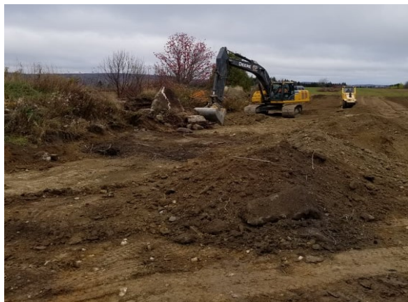
Démantèlement de la digue de roches
